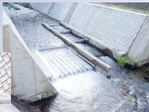
河川設置状況
