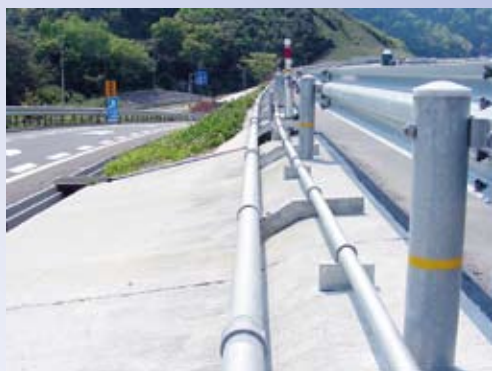
送・散水管布設状況
