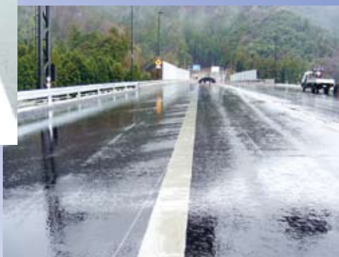
散水管(保護コンクリート巻)配管
